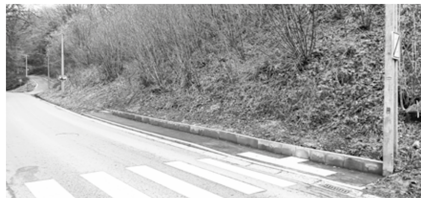
Domage ! Le trottoir s'arrête au début d'un chemin pentu plutôt que de se prolonger jusqu'à la route menant à l'IMP.
