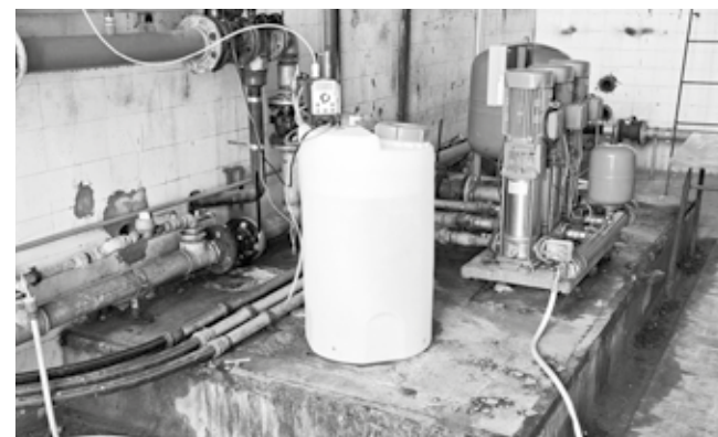
Les installations de traitement et de pompage de l'eau de source de l'asbl Institut Saint-Berthuin
