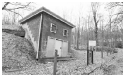
Le réservoir de Bauce, dans le Bois de la Vecquée, côté Sambre
