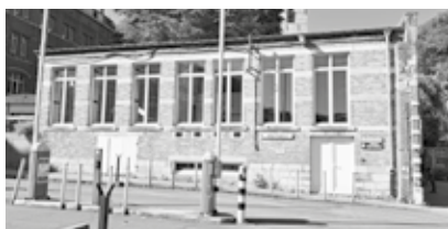
Bâtiment de la station de pompage de l'asbl Institut Saint-Berthuin
