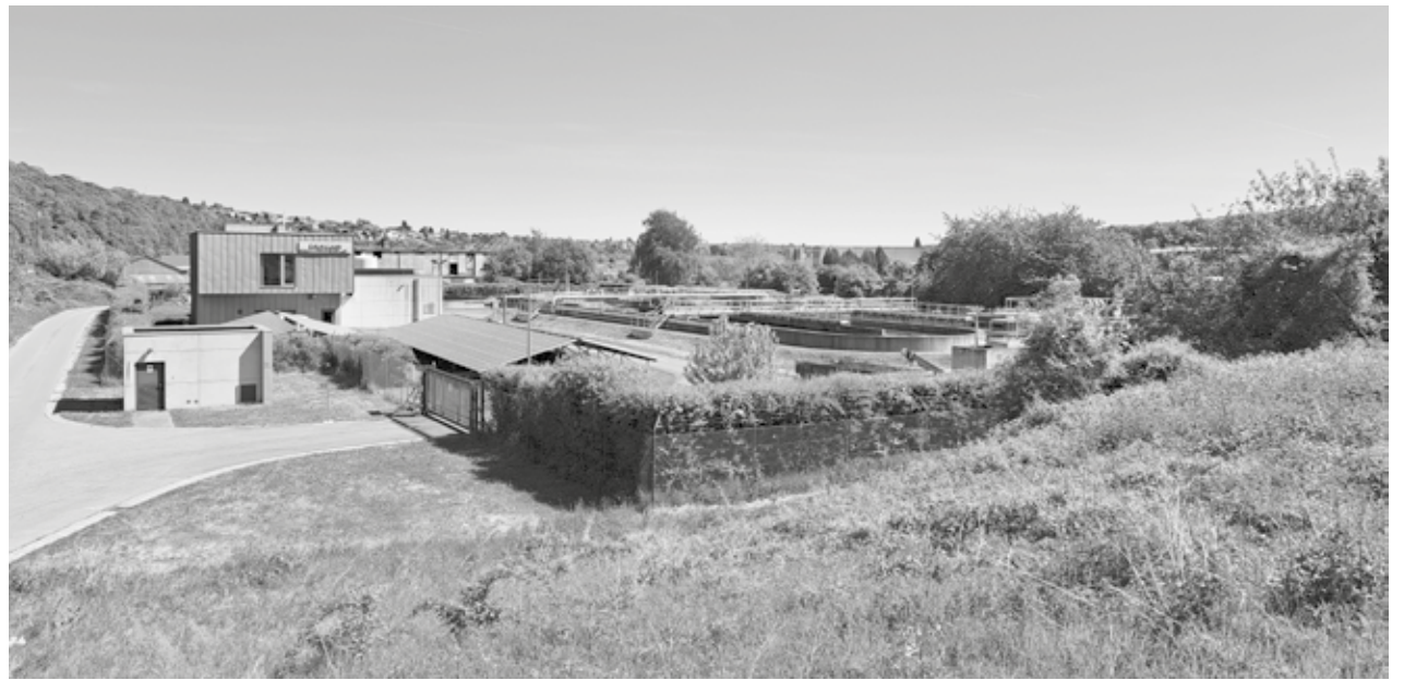
La Station d'épuration de Floreffe
